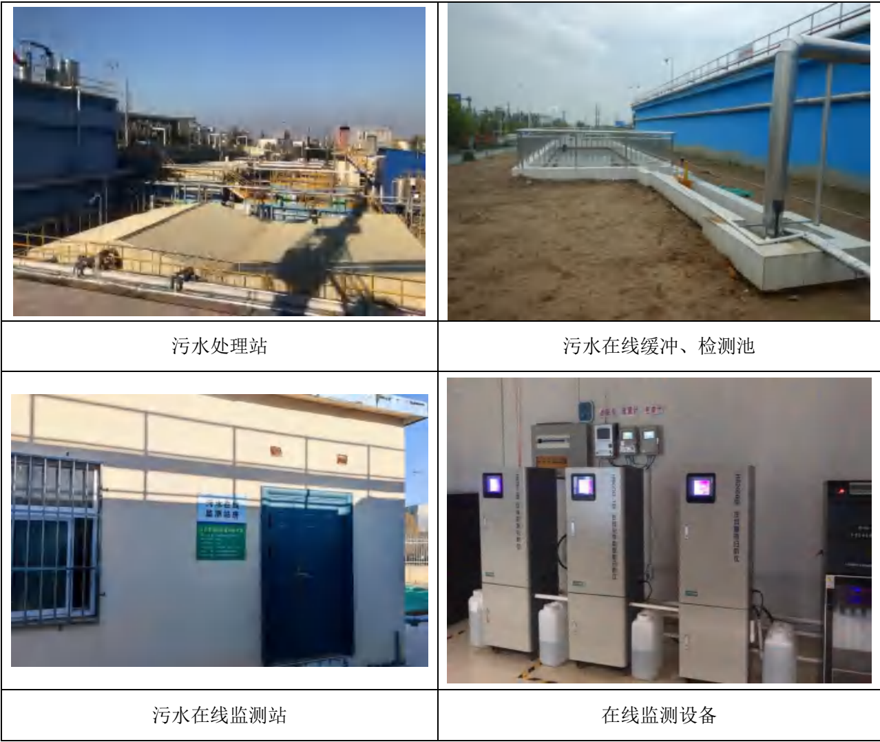
图 4-3 污水处理站及在线监控室建设情况图
